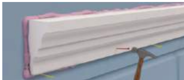
● Clavos de apoyo. ● Clavos de sujeción temporal.
