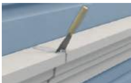
4. Rellenado de la junta.
