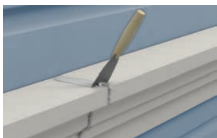
4. Rellenado de la junta.
